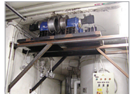
To af MAC800 motorerne installeret.
